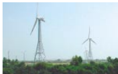
インドの風力発電施設
